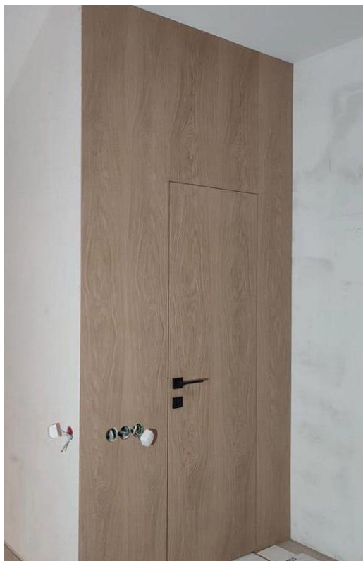
Скрытый алюминиевый короб + стеновые панели 10мм
